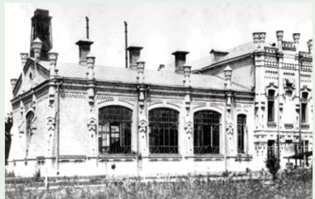
Пятигорская тепловая электростанция
