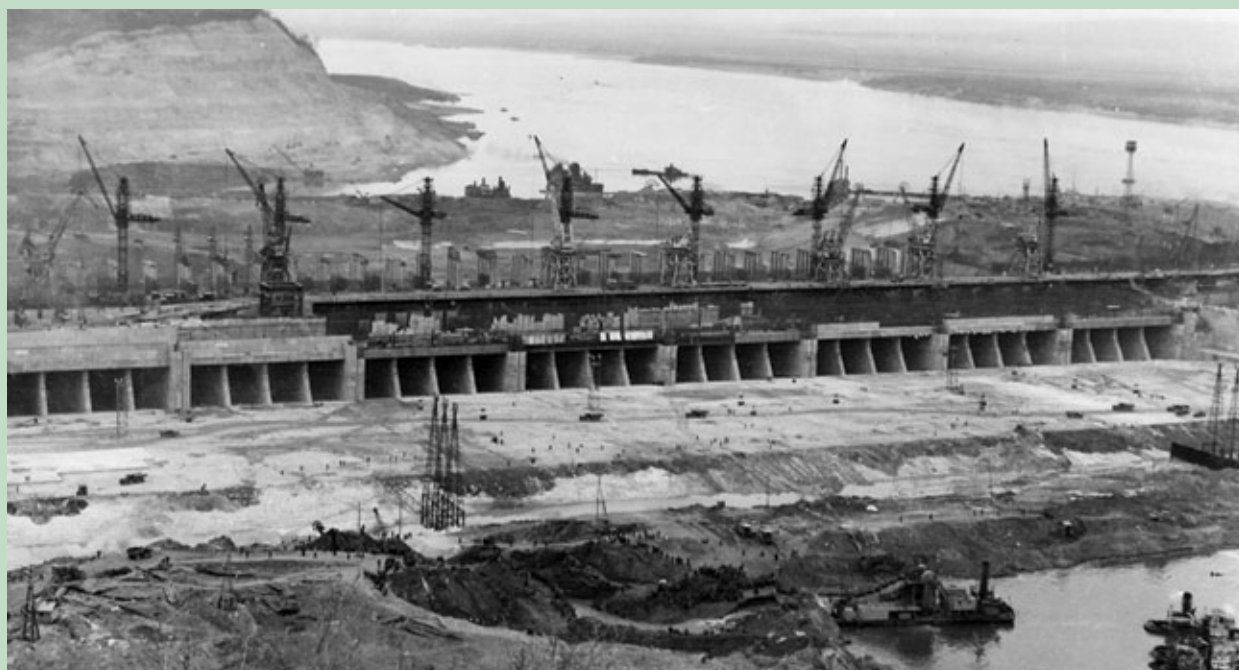
Строительство Куйбышевской ГЭС
