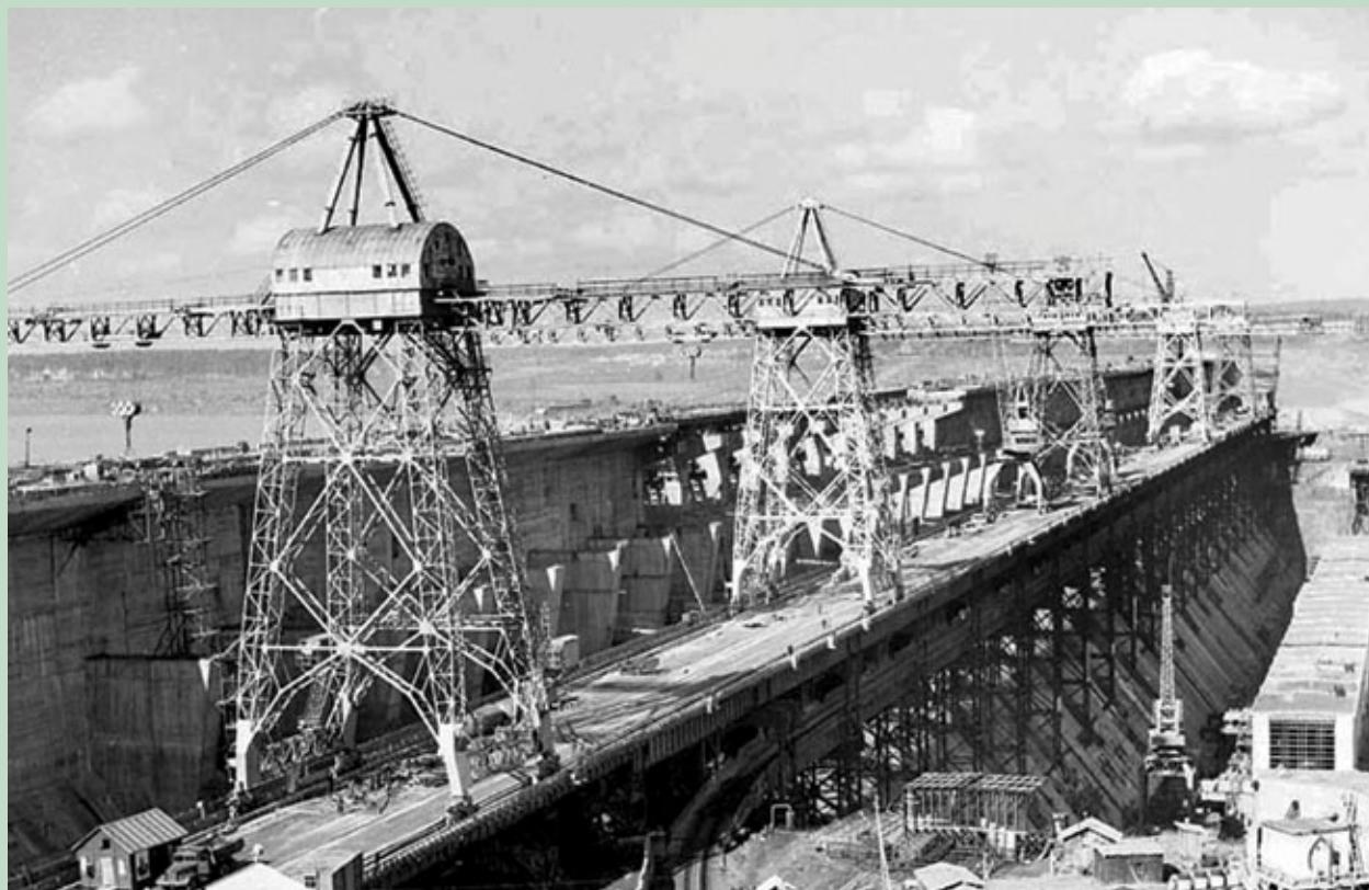
Строительство Братской ГЭС
